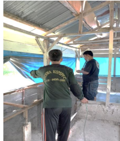
(Proses pemasangan terpal)
