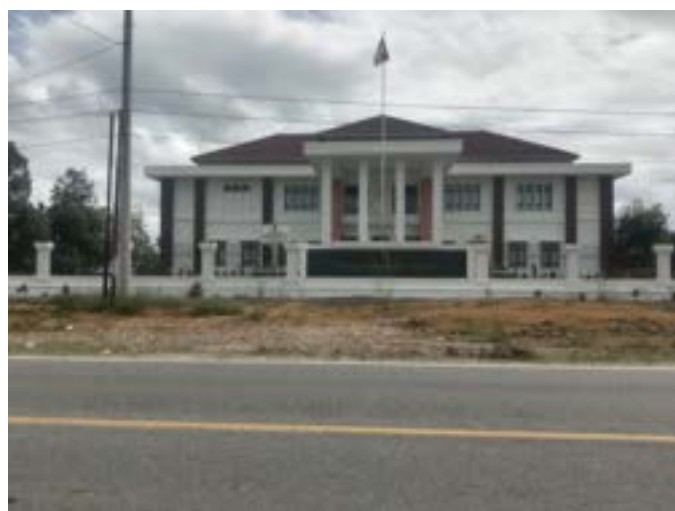
Gambar 4.2 Bangunan Pengadilan Negeri Teluk Kuantan Sumber : dokumentasi lapangan
