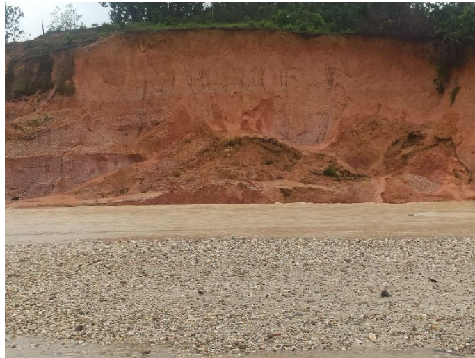
Gambar 1.1 Kondisi Lereng Sumber : Dokumentasi Lapangan
