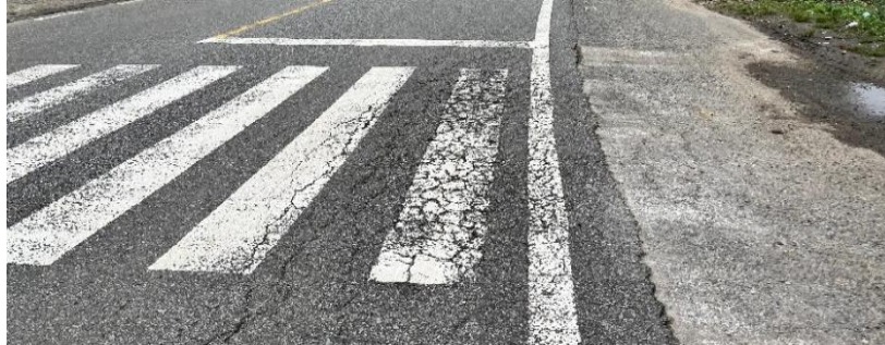
Gambar 2.5 Retak Kulit Buaya.
