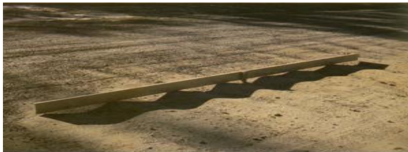
Gambar 2.11 Bergelombang ( Corrugation ).
