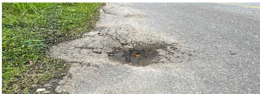
Gambar 2.6 Retak pinggir.
