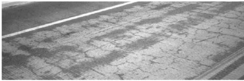
Gambar 2.8 Retak Susut.
