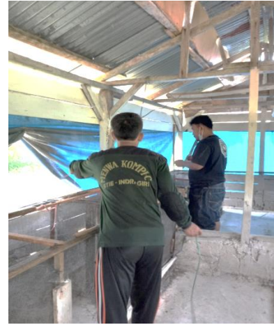
(Proses pemasangan terpal)
