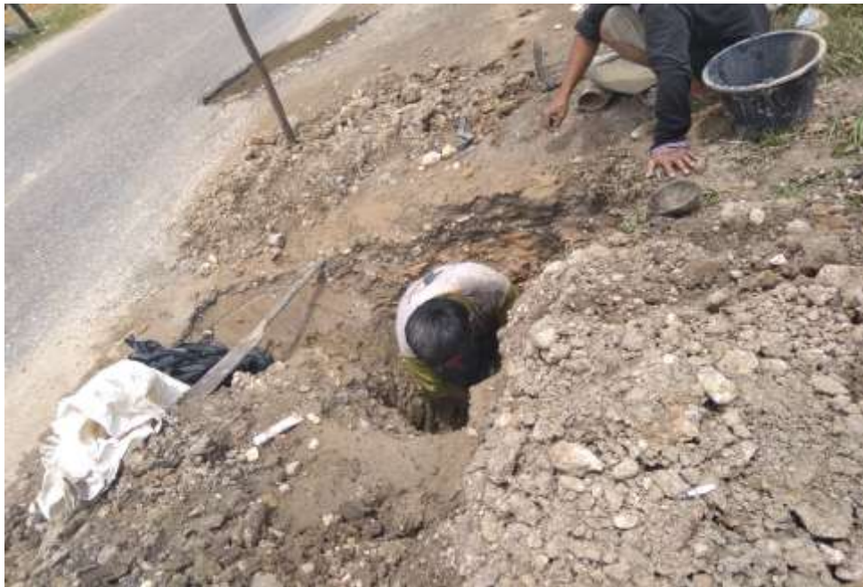
Proses perbaikan pipa Penyediaan Air Bersih (PAB) Unit Pangean yang rusak di tepi jalan raya di desa Pasarbaru, Pangean oleh petugas.
