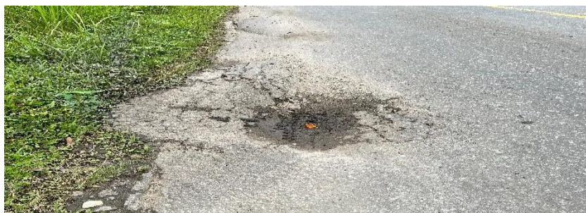
Gambar 2.6 Retak pinggir.
