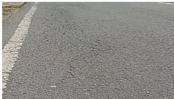
Gambar 2.6 Retak Pinggir
