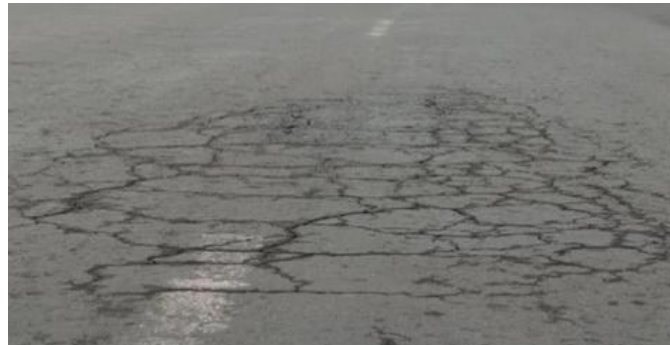
Gambar 2.5 Retak Kulit Buaya
