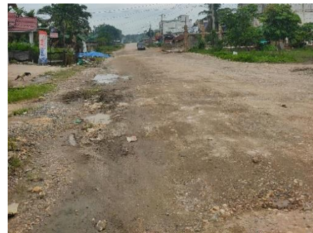
Sumber : dokumentasi lapangan Gambar 3. 3 kondisi lapangan
