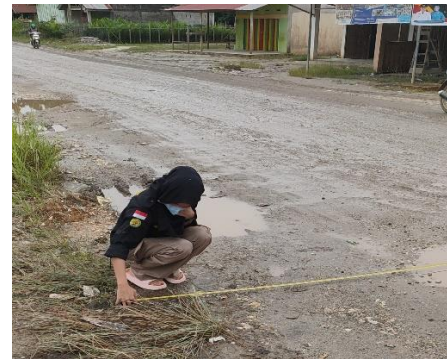
Sumber : dokumentasi lapangan Gambar 3. 5 kondisi lapangan
