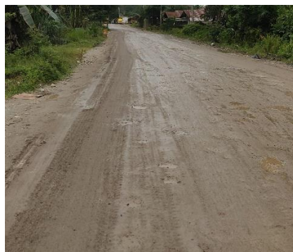
Sumber : Dokumentasi lapangan Gambar 3. 4 kondisi lapangan
