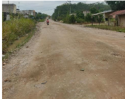
Sumber : dokumentasi lapangan Gambar 3. 2 kondisi lapangan
