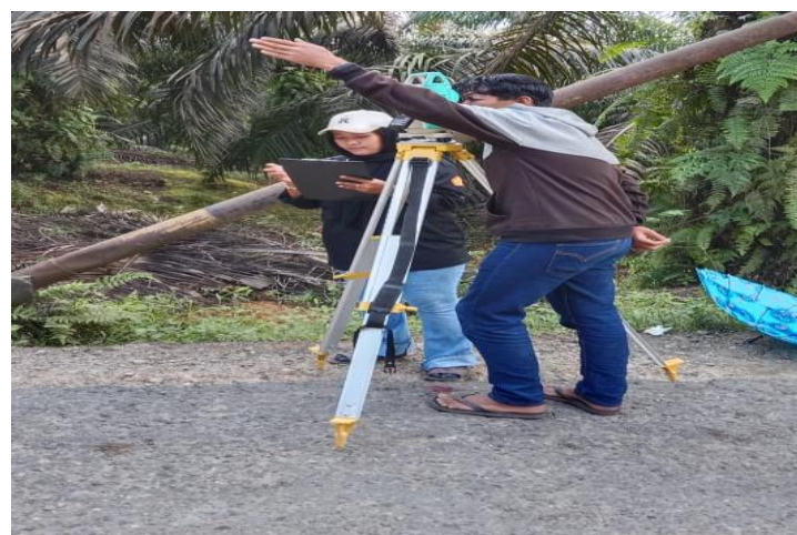
Sumber : Hasil Dokumentasi Resta Yurinda (2025) Gambar D.5 Pengambilan Data Alinyemen Jalan
