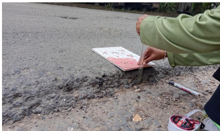
Sumber : Hasil Dokumentasi Resti Yurinda (2025) Gambar D.2 Pengukuran Untuk Tebal Jalan
