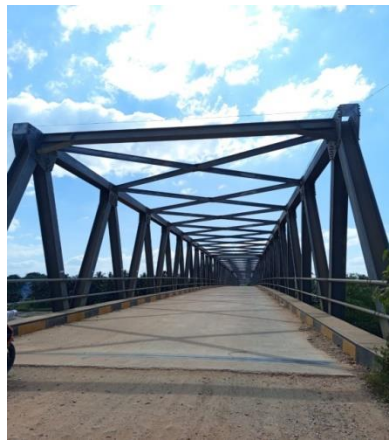
Gambar 2.1 Jembatan Gunung Toar
