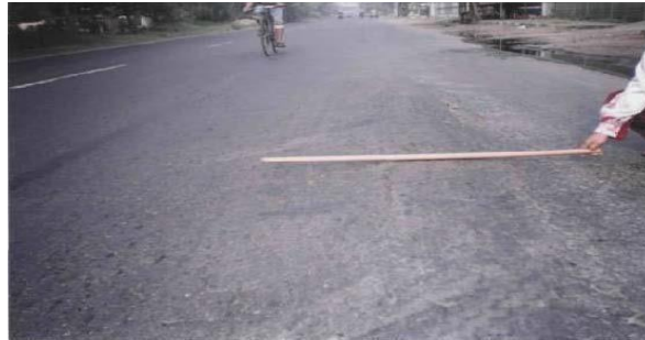
Gambar 2.18 Mengembang Jembul ( Swell ) Sumber : Bina marga no.03/MN/B/1983
