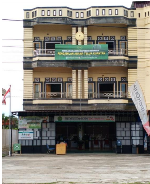
Gambar 2.3 Kantor Pengadilan Agama Teluk Kuantan(Ruko 3 Lantai)
