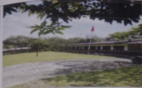
Gambar 1: Gedung SDN 009 Seberang Taluk
